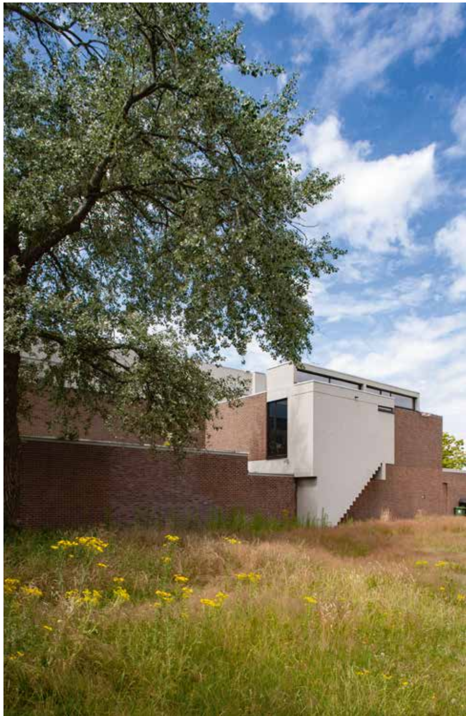
Marc Dessauvage, Sint-Jozef Arbeiderkerk in Vosselaar, gezicht op de oostgevel (foto Oswald Pauwels)
