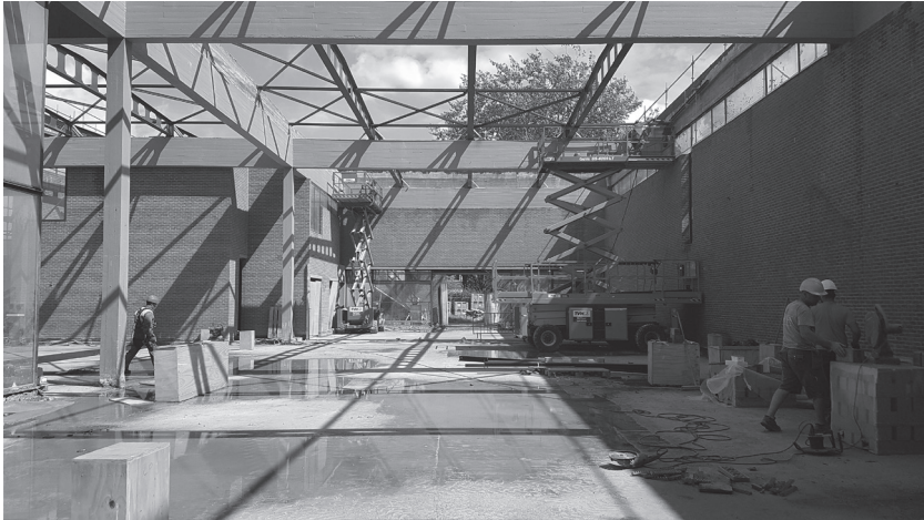
De Sint-Jozef Arbeiderkerk tijdens de herbestemmingswerken. Op de foto is de betonnen structuur goed te zien. Beeld Monument Goedleven, 2019.
