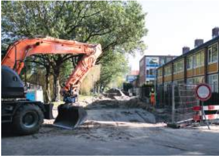
Aanleg van warmtenet in Selwerd, 08/10/2021 - foto: Pieter de Ruijter.
