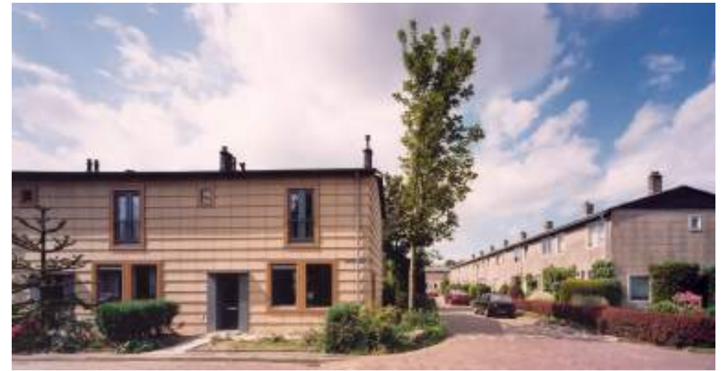
BIQ architecten/Hans van der Heijden Architect maakte het ontwerp voor de renovatie van tuindorp Kethel in Schiedam. Het bureau koos voor een grondige gevelrenovatie, die het originele aspect van de wijk bewaarde. De ingrepen werkten rondom de eerdere interieuraanpassingen van de bewoners. Door twee proefblokken te maken kon de aannemer de uitvoering gericht voorbereiden en konden de bewoners het ontwerp in de realiteit beoordelen - foto: Piet Rook, Vlaardingen.
